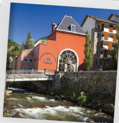
Centre Thermal Le Teich
